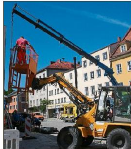
Die Aufbauarbeiten begannen am Montagmorgen. Fotos: Wühr
