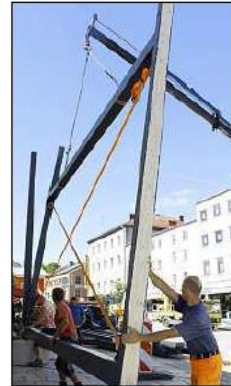
Das Holztragwerk für die Bühne nimmt am Montagmorgen erste Formen an.
